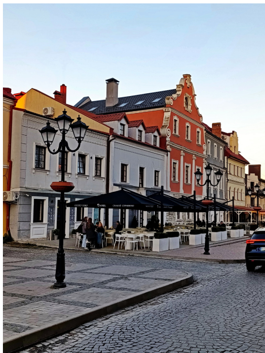
Відреставровані фасади кам'яниць на північному боці Ринку
