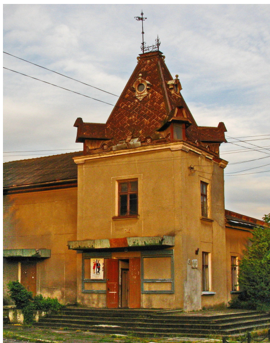
Колишня будівля товариства «Сокіл» у Заліщиках, 1903 рік
